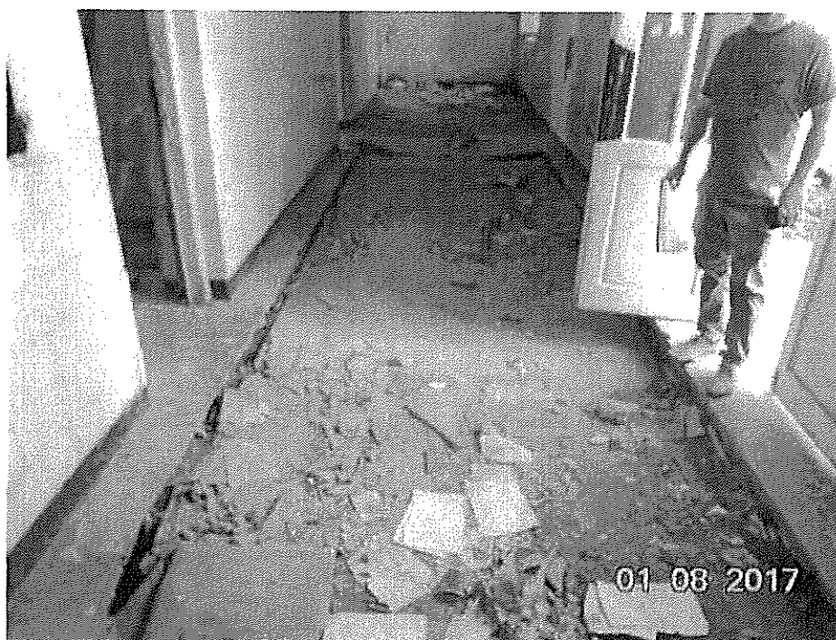
Foto 12- Tasare a pamantului pana la 30cm in interiorul corpului C2 - pe hol,
