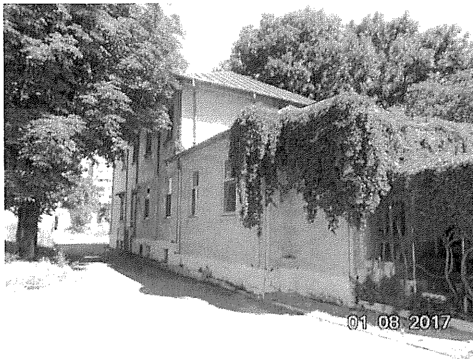
Foto 1- Fațada vest (C2)
